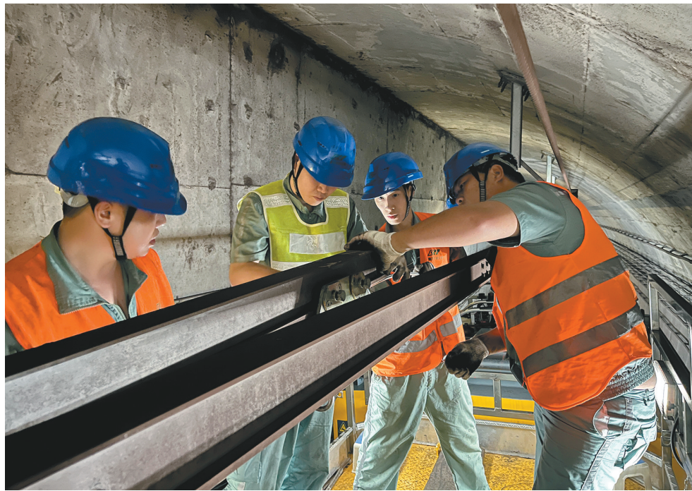
更换接触线作业
