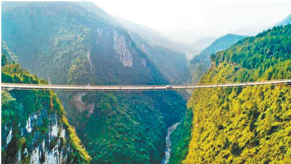
武隆区长坝镇峡谷,长245米、远望“薄如纸片”的一座索道桥,“悬挂”在300米高空。桥上,45吨重工程车也能平稳行驶;桥的两侧,是让人望而生畏的悬崖峭壁。
