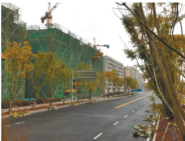
花石沟站附近正在修建的洋房项目
