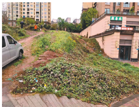
3号车库出入口的道路修建前
