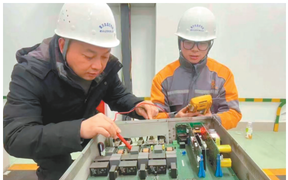
四号线公司供电检修车间主任梁晓洪用万用表排查设备故障点
