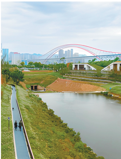
整治后的溉澜溪(部分)
