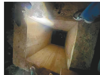
◀涉事消防水井
